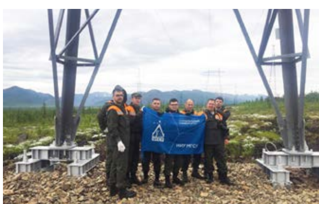
Комплексное обследование ЛЭП в интересах ПАО «РусГидро»
