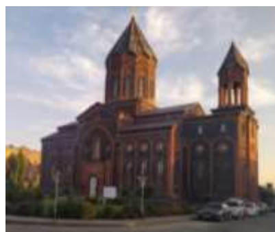
Церковь Сурб Аменапркич (1858—1872). Гюмри. Архитектор Т. Андикян
