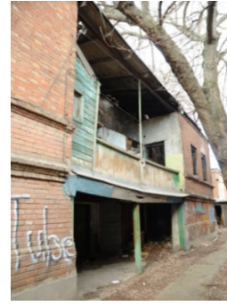
Рисунок 154. Дом архит. Григоряна. Дворовой фасад. Фотография 2019 г.
