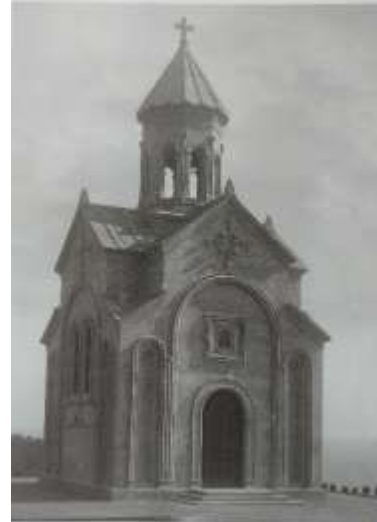
Церковь Святой Нины в имении «Харакс». Мисхор. Архит. Н. П. Краснов. Фотография Н. П. Краснова, нач. XX (Калинин Н., Кадиевич А., Земляниченко М. Архитектор Высочайшего Двора...)
