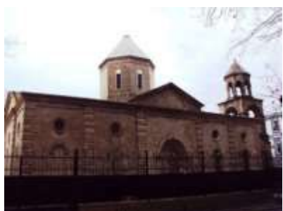
Церковь Сурб Григор Лусаворич (1860-е гг.). Баку. Архитектор К. Г. Гипшиус
