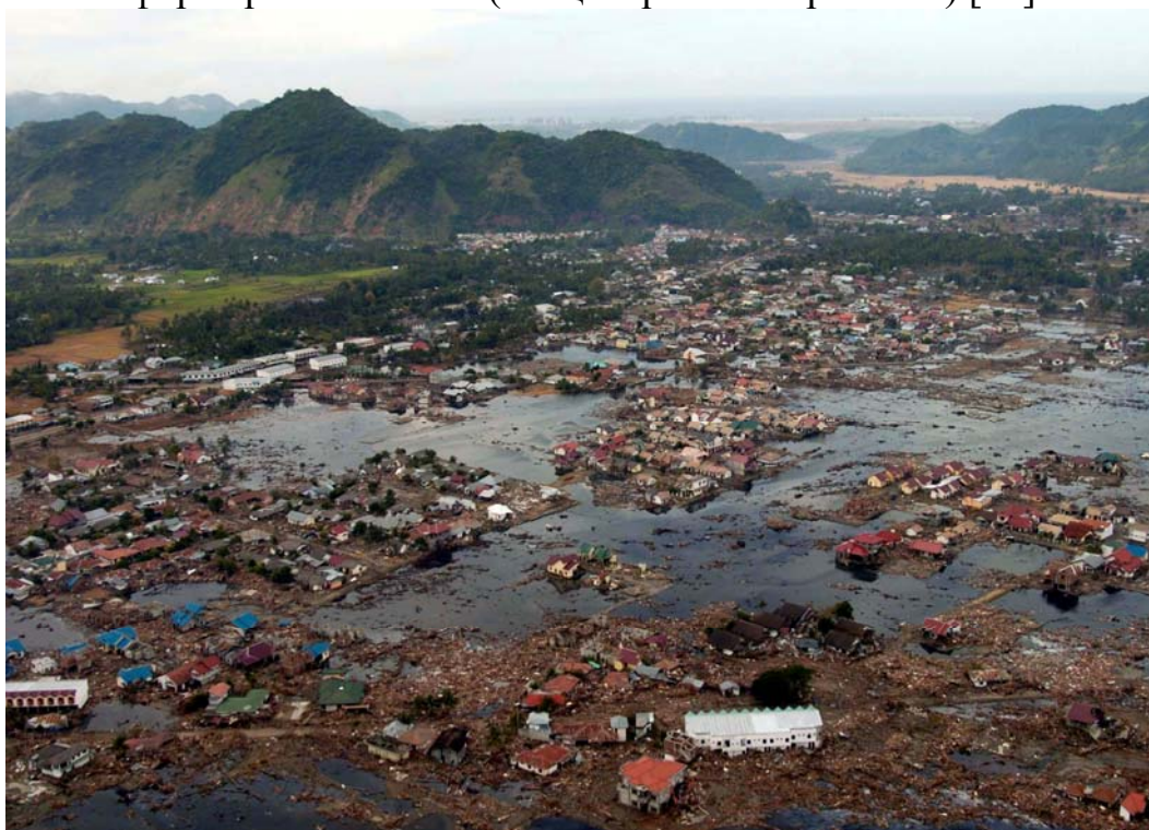
Рисунок 1.5 – Последствия цунами в Индийском океане в 2004 году [14]
