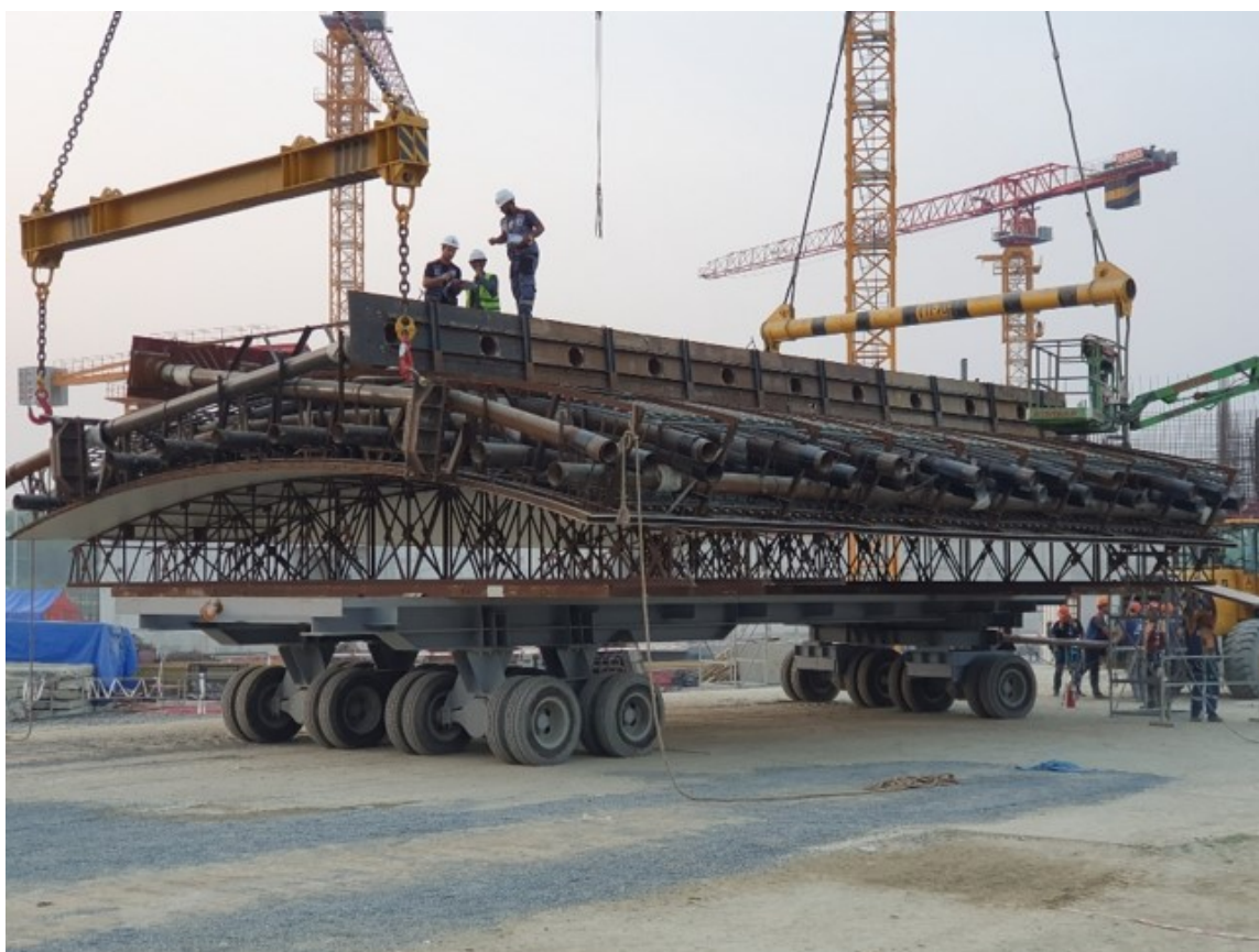
Рисунок 1.7. Перевозка армоблока ВЗО на прицепе по территории площадки строительства (АЭС «Рупшур», Народная Республика Бангладеш).
