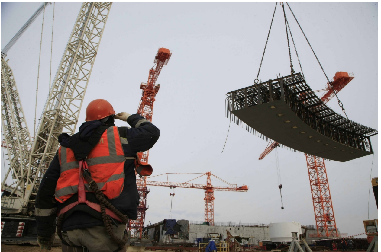
Рисунок 1.3. Монтаж армоблока перекрытия кольцевого коридора со стальной опалубкой на Курской АЭС-2.
