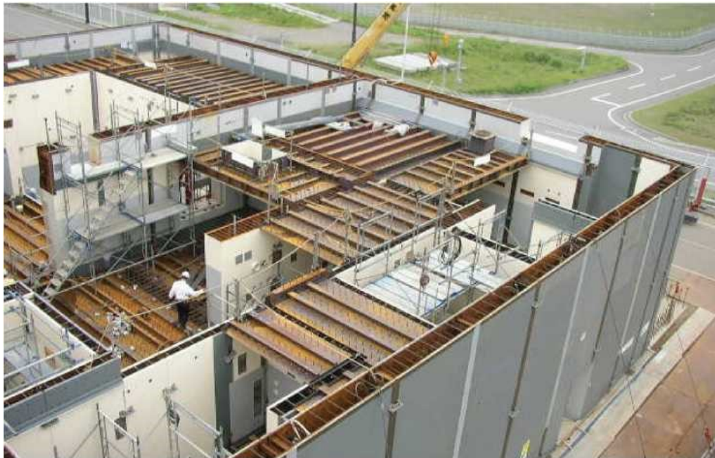
Рисунок 1.10. Здание, возводимое по технологии steel-plate composite.
